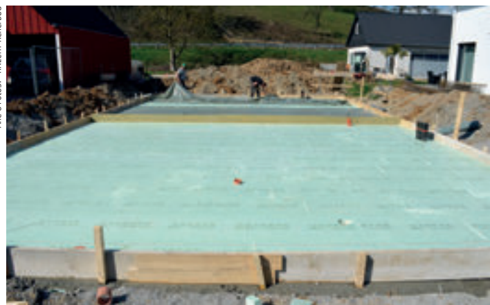
Die Dämmung wird heute üblicherweise unter der Bodenplatte direkt auf die Splittschicht gelegt; nach Einbringen der Bewehrung entsteht durch Ausgießen & Verdichten von Ortbeton die tragende Bodenplatte.
