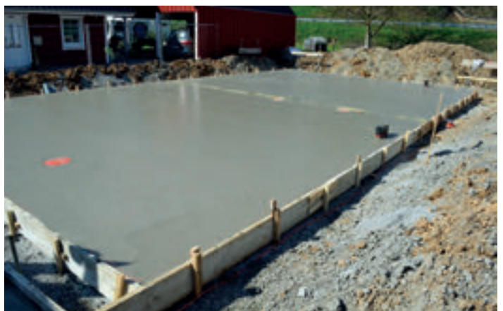
Die Dämmung wird heute üblicherweise unter der Bodenplatte direkt auf die Splittschicht gelegt; nach Einbringen der Bewehrung entsteht durch Ausgießen & Verdichten von Ortbeton die tragende Bodenplatte.
