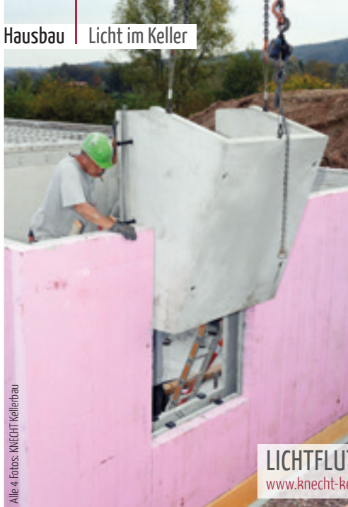
Präzisionsarbeit: Der Original Lichtfluter wird von KNECHT Kellerbau im Werk vorgefertigt und auf der Baustelle exakt eingesetzt.
