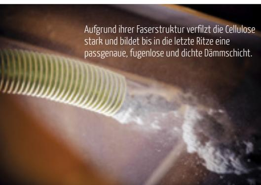
Aufgrund ihrer Faserstruktur verfilzt die Cellulose stark und bildet bis in die letzte Ritze eine passgenaue, fugenlose und dichte Dämmschicht.
