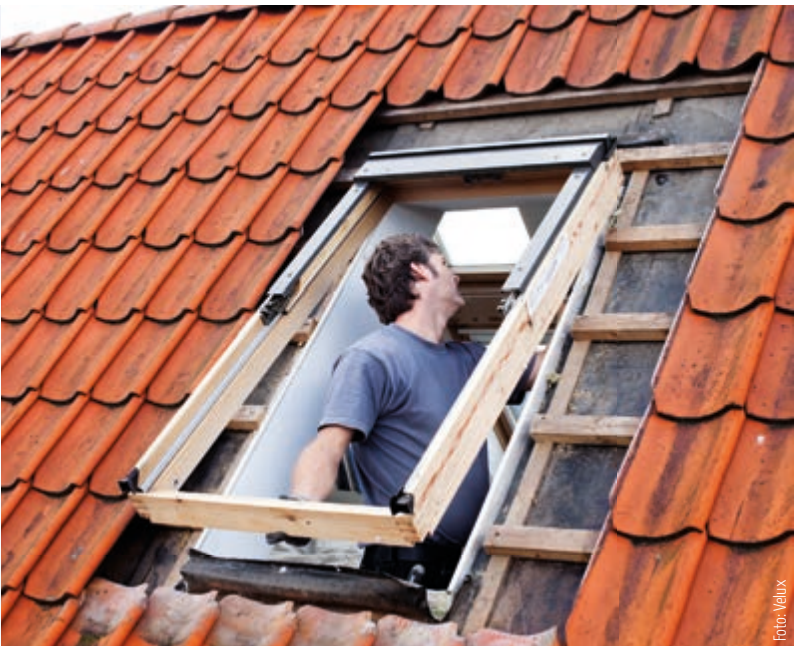
Der Austausch alter Dachfenster gegen neue Modelle mit Dreifach-Verglasung kann den Bedarf an Heizenergie um 17 Prozent senken.
