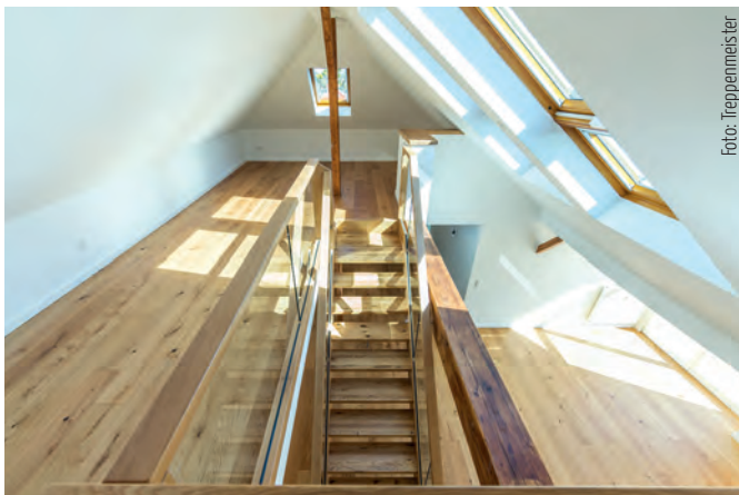
Holztreppen eignen sich aufgrund ihres relativ geringen Gewichts besonders für Aufstockungen.
