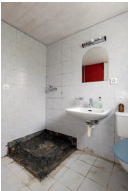
Im ersten Schritt musste die bestehende Duschkabine und die stahl-emaillierte Duschtasse demontiert und entsorgt werden.
