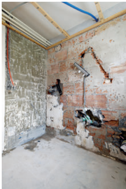
Auch die Holzdecke wurde entfernt, Wasser- und Abwasserleitungen sowie Stromanschlüsse wurden angepasst und an die richtige Stelle versetzt.
