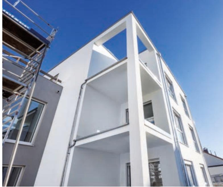
Dank des Einsatzes von 1.530 m<sup>2</sup> VARIAX Spannbeton-Hohldecken konnten bei diesem Projekt 33 Prozent Beton und damit 45 Tonnen CO<sub>2</sub> gegenüber Massivdecken gespart werden. Der Holzanteil wiederum dient als CO<sub>2</sub>-Speicher. Denn Bäume entziehen der Luft beim Wachsen Kohlendioxid und lagern es ein. Verbaut man den natürlichen Rohstoff, bleibt das Kohlendioxid darin langfristig gebunden, was der Ökobilanz von Hybridbauten und damit der Umwelt zugutekommt.
