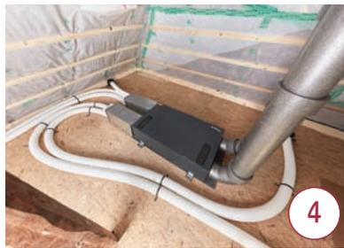
1. Bei der Installation der Zehnder Komfort-Lüftungssysteme wurden die Lüftungsrohre über der abgehängten Decke verlegt. Vom Abstellraum aus verlaufen sie in die übrigen Räume. Formteile, wie der Zehnder Verteiler flat 51 zur Verteilung der Luftmengen auf die einzelnen Rohrleitungen, erleichtern die Verlegung und sparen Zeit bei der Montage.
