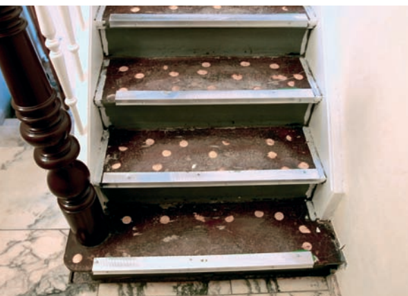
Der Treppenmonteur überbaut alle alten Stufen mit den neuen PORTAS-Trittstufen, ergänzt die typischen Stellstufen und versiegelt die Ränder.
