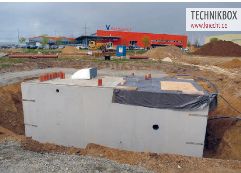
Die Neuentwicklung wird von KNECHT im Werk industriell vorgefertigt und steht schon nach einem Tag. Später wird darüber einfach die Bodenplatte des Hauses betoniert.
