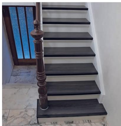
Der Treppenmonteur überbaut alle alten Stufen mit den neuen PORTAS-Trittstufen, ergänzt die typischen Stellstufen und versiegelt die Ränder.
