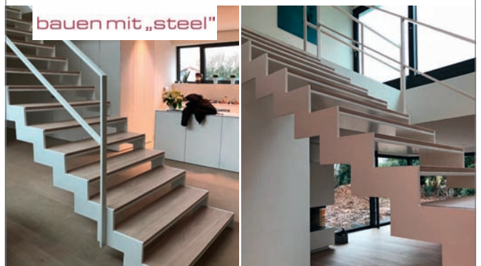
Wangentreppe mit Holzstufen
