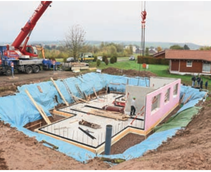
Blick zurück: Das Fundament ist gesetzt.
