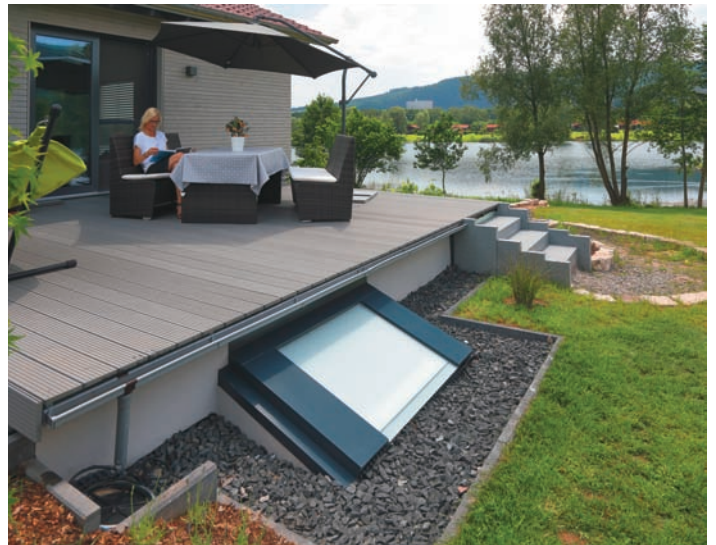
Für den Lichtfluter dachten sich die Bauherren eine sichtgeschützte Abdeckung aus, die sie individuell gestalteten.
