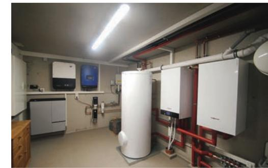
Für das Haustechniksystem findet sich in einem separaten, rund 13 Quadratmeter großen, Kellerraum die eigene Technikzentrale. Hier sind die Komponenten für die Außen-Luftwärmepumpe, die das Haus beheizt, installiert, genauso wie der Batterie-Speicher, in den der erzeugte Sonnenstrom eingespeist wird sowie alle weiteren benötigten technischen Medien.
