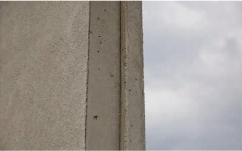
Für innen gibt es die Fertigwände bereits ab einer Stärke von nur 13,2 Zentimetern. Gemauerte tragende Innenwände weisen gewöhnlich eine Stärke von mindestens 17,5 Zentimetern auf.
